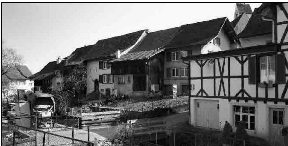
Abbildung 24: ISOS Bennwil und Foto traufseitige Zeilenbebauung mit offenem Bachlauf, Quelle: ISOS
